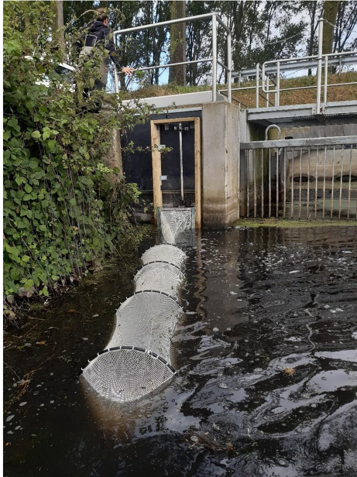
Figuur 3 – Foto van de fuikeconstructie aan het Geleed Noord (boven). Het aansluitende houten frame zorgt ervoor dat de volledige opening wordt afgesloten zodat vissen enkel in de fuike kunnen zwemmen. Foto van de opstelling aan het Geleed Zuid (onder).
