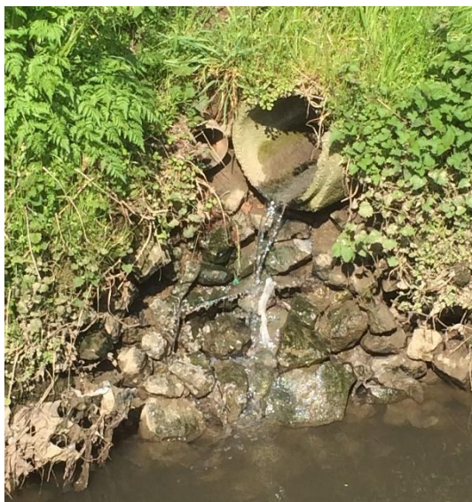
Figuur 16: Buis met mogelijk afvalwater gelegen op het afgeviste traject op de Steenvoordebeek (657).
