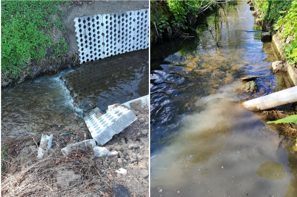
Figuur 3: Foto van het vismigratiekelpunt ter hoogte van de brug over de Lange Akkerstraat in Meigem (links, Iñaki Colpaert) en lozing van afvalwater (rechts, Michiel Puype).
