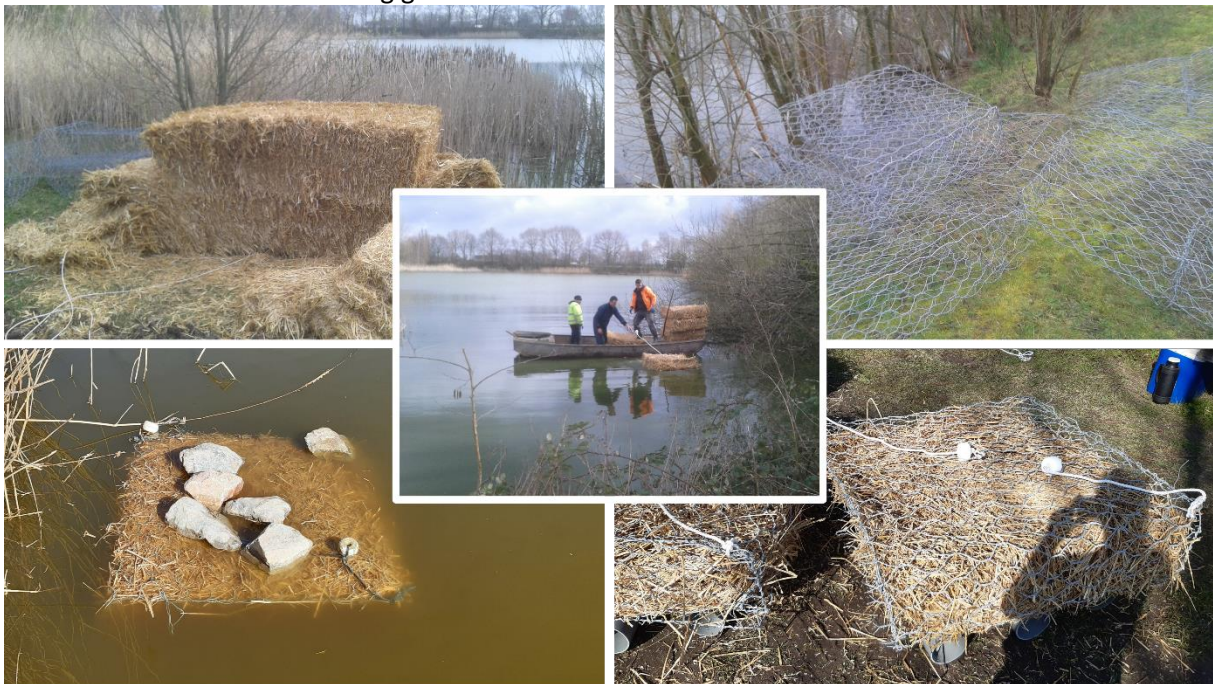
Figuur 1: Centraal: plaatsing van de balen gerstestro. Linksboven: balen onbewerkt gerstestro. Rechtsboven: lege schanskorven. Rechtsonder: Losgeschud gerstestro in schanskorf met ondergebonden PVC-buizen en drijvers. Linksonder: geplaatste schanskorf met aantal kasseien op de schanskorf om bovendrijven tegen te gaan.
