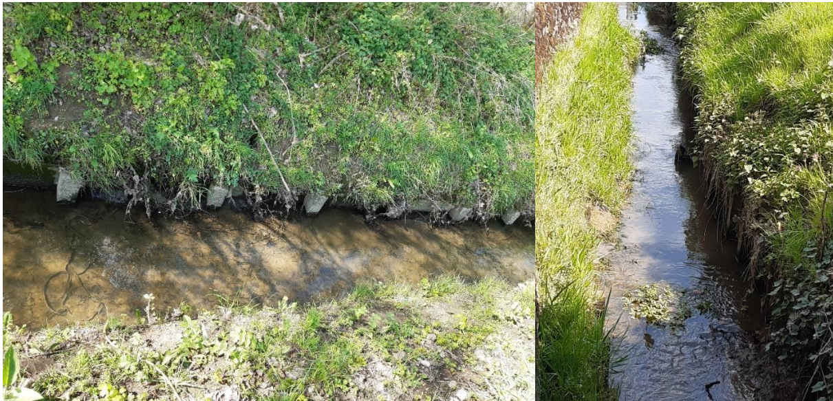
Figuur 9: Links: Steenborrebeek aan locatie 392. Rechts: Juffrouwbeek aan locatie 389. Beide trajecten afgepaald en rechtgetrokken.
