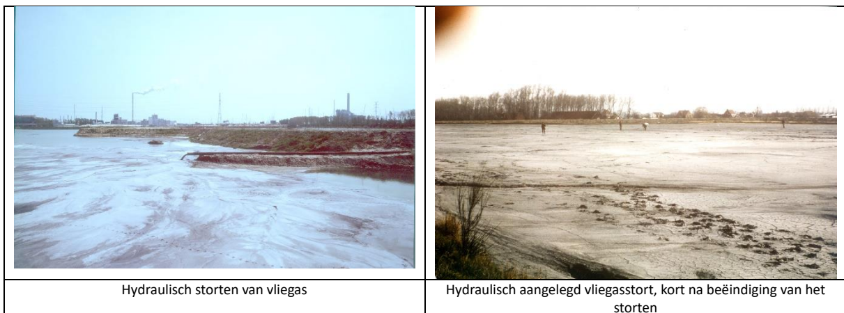
Figuur 3 : hydraulische aanleg van vliegastort
