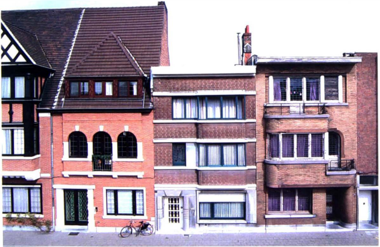
Guido Gezellelaan nr. 10, in 1938 ontworpen door Robert Hebb voor Antoon Pincé. Het nr. 9 dateert eveneens van 1938 en is ontworpen door Hilaire De Boom. Het nr. 11 dateert van 1939 en is van de hand van Charles Hoge.
