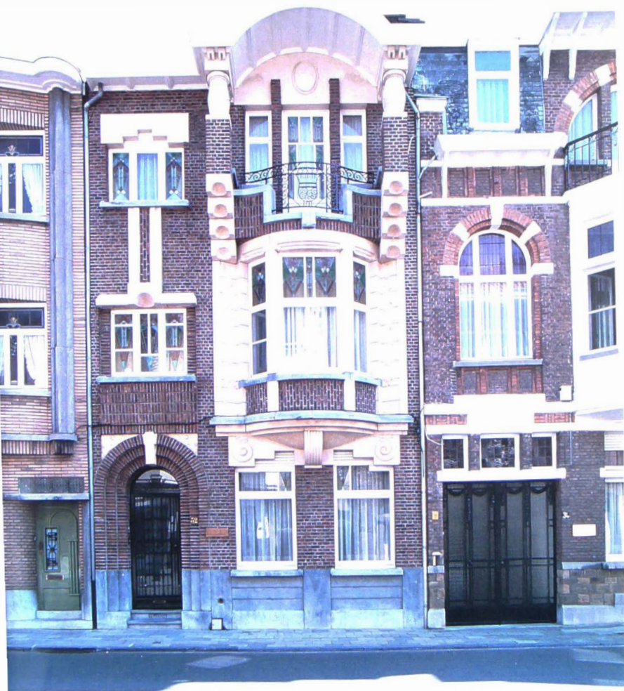
Mgr. Stillemanstraat nr. 32, in 1931 ontworpen door de architecten Waterschoot voor Alfons Spaenhoven.
