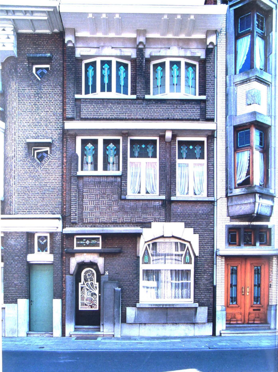
Mgr. Stillemansstraat nr. 26, in 1932 ontworpen door de architecten Waterschoot voor Gust Van de Vijver en zusters.
