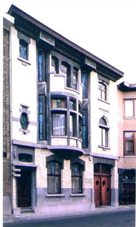
Mgr. Stillemanstraat nr. 38, in 1931 ontworpen door de architecten Waterschoot voor Frederik Dirken.
