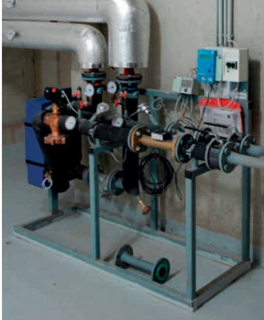
Onderstation appartementsgebouw, vermogen 300 kW, afmetingen 1 x 0,5 x 1m (Danfoss)
