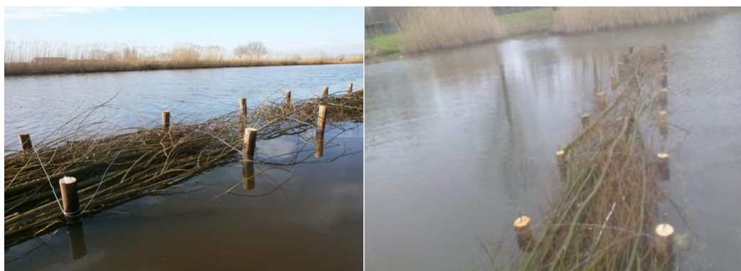
Figuur 6 – Twee voorbeelden van takkenbossen die beschutting geven tegen golfslag (bron: www.vissenbos.nl )
