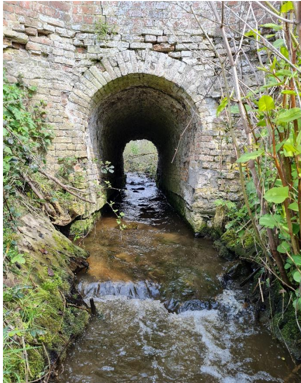
Figuur 4: foto van de stroomafwaartse zijde aan het brugje op locatie 660. Aan de overloop van de bodemplaat naar de waterbodem is het luchtgordijn duidelijk zichtbaar.
