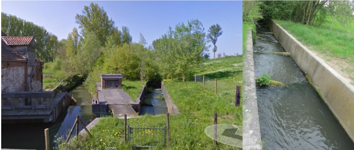
Figuur 1: Zicht in stroomafwaartse richting op de bekken trap aan de Boembekemolen. LINKS: overzichtsfoto van de locatie, RECHTS: detail van de bekken trap zelf.
