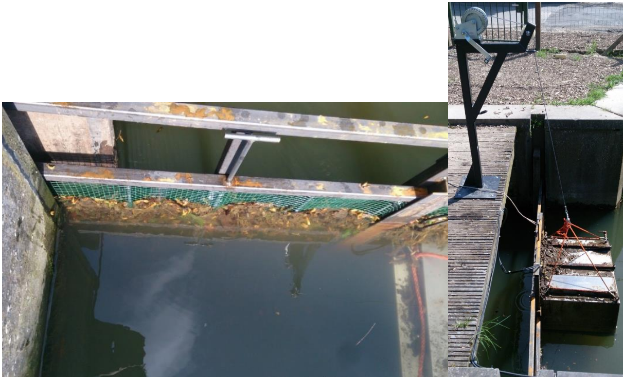
Figuur 7: LINKS: Zijpaneel waar zich organisch materiaal tegen heeft verzameld. RECHTS: de box tijdens het naar boven takelen. Let op de schuine kabel waardoor de lier onder spanning komt te staan.
