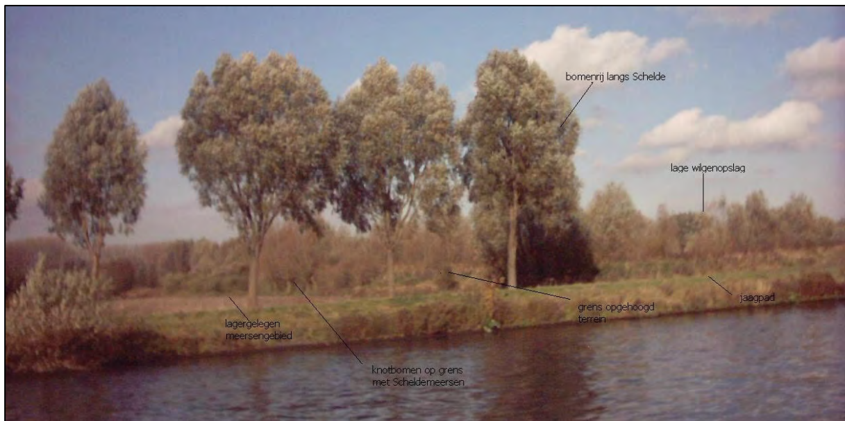
Westelijke grens van het bedrijventerrein / opgehoogd terrein anno 2003
