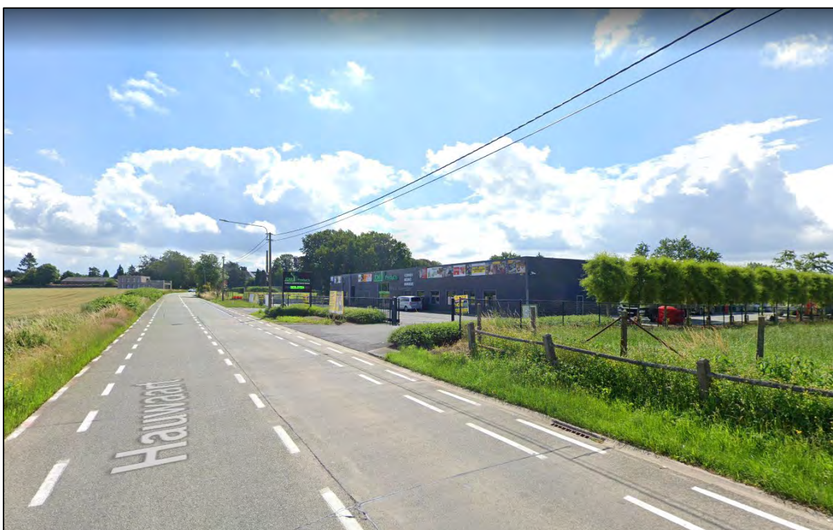
Foto 2: Zicht op het vergunde bedrijfsgebouw van het toenmalige groothandelsbedrijf JDM Products vanop de N8 (Bron: Google Street View, juli 2021)
