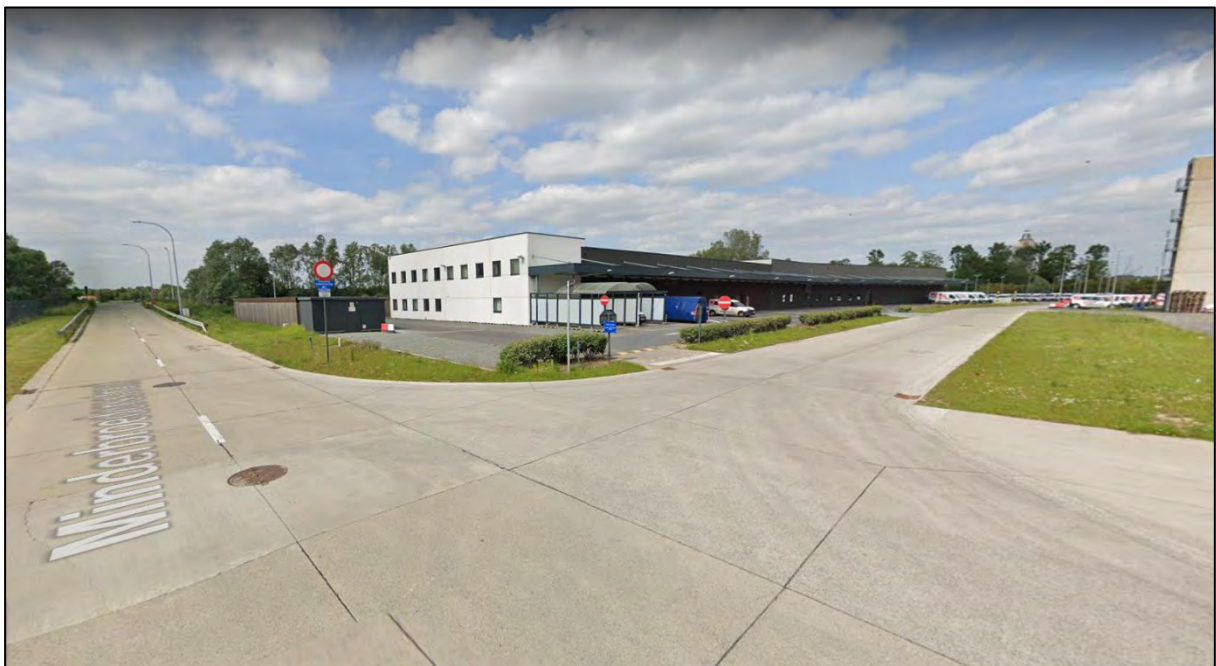
Foto 5: Zicht op de zijtak van de Minderbroedersstraat met rechts het verdeelcentrum van bpost (Bron: Google Street View, mei 2019)
