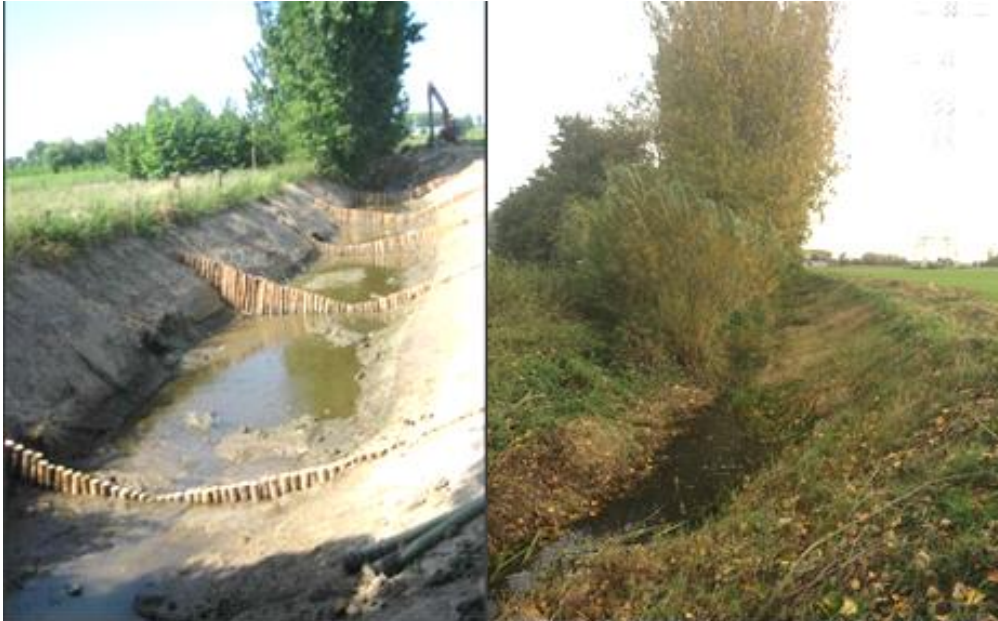
Figuur 12: Vistrap in de omgeving van de monding van de Neerschuurbeek in de Poekebeek op het moment van de aanleg (links, foto Marnix Coulier) en in 2022 (rechts).
