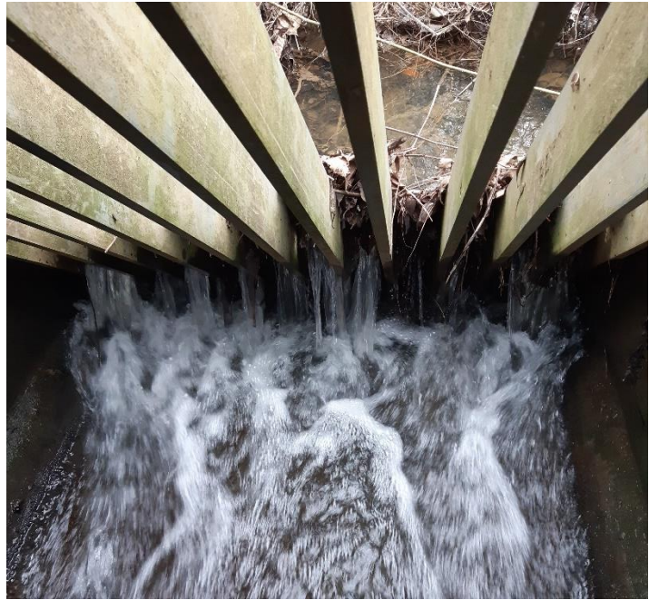
Figuur 2: Rooster op de bypass van de Zwalmbeek in Brakel welke een vismigratiekelpunt vormt door ophoping van allerlei materiaal.
