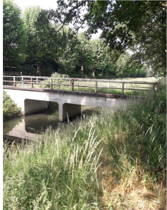
Figuur 2: Brug over het traject van locatie 611, enkele meters stroomopwaarts van het Duivelsput pompgemaal.
