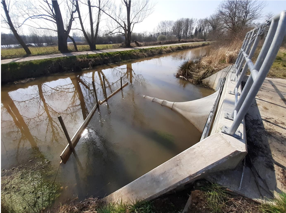
Figuur 18 – Foto van de drijfbalken die werden aangebracht om opstuwung te voorkomen.
