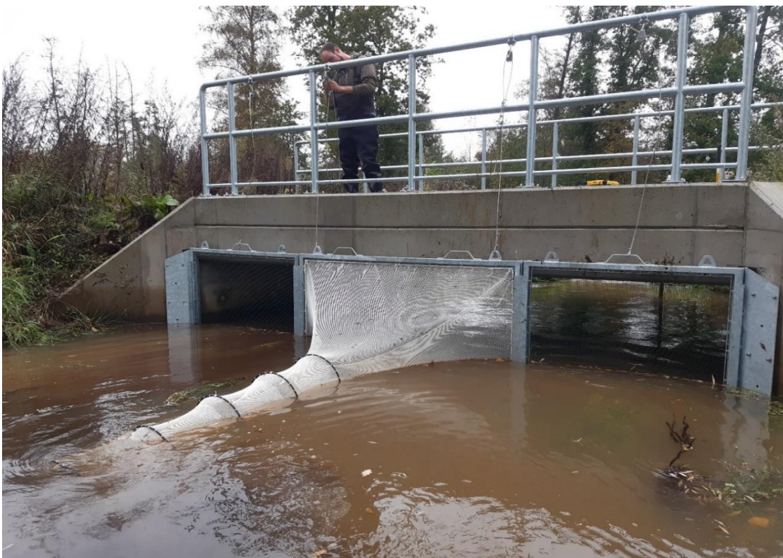
Figuur 3 – Foto van de fuikconstructie aan het Malesbroek op de Grote Nete. De twee zijvleugels (1m) werden voorzien van een fijnmazig gaas (0.9X0.9cm) om de vissen doorheen de fuik zelf te sturen. De ingang van de fuik zelf was 2 meter breed.
