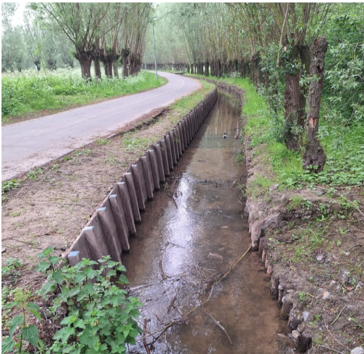
Figuur 10: tijdens het voorjaar van 2026 werd de Volkaartsbeek door de provincie Oost-Vlaanderen verbreed en geruimd om de waterafvoer te kunnen verzekeren.
