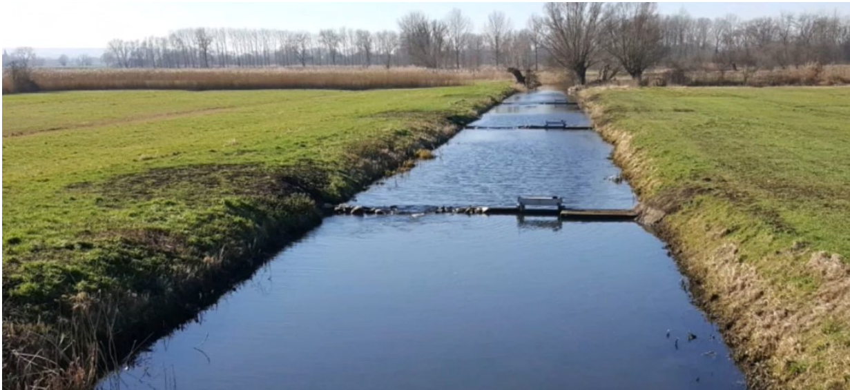
Figuur 5: Op de foto zijn stuwen 2, 3 en 4 te zien in gesloten toestand.
