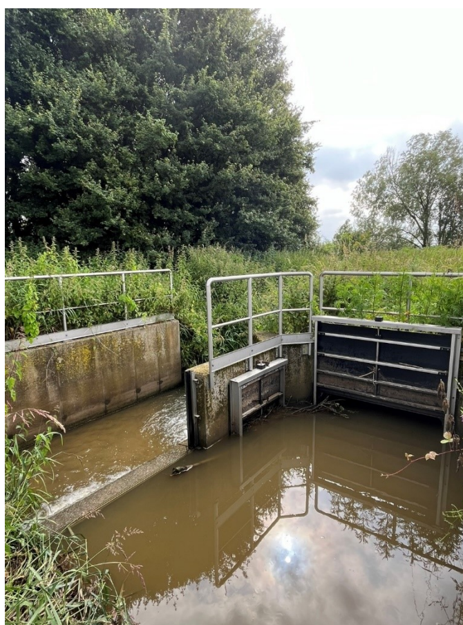
Figuur 9: Referentiesituatie op het terrein: verdeelconstructie Donk 1. Deze foto is gemaakt voor de werken die uitgevoerd zijn in 2026 om de beek te ruimen. In deze situatie staan beide schuiven open ©Floris Huyghe.
