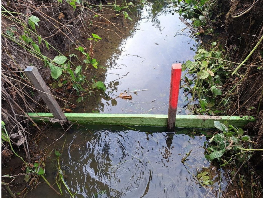
Figuur 2 - Planken geplaatst als tijdelijk vismigratieknelpunt in de Dorenbosbeek om te vermijden dat vis na de visredding terug het afgeviste traject zou koloniseren. ©Mechtild Zoeter Vanpoucke.
