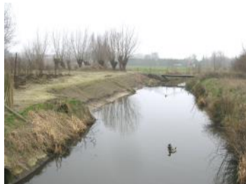
Oeverafschuining voor rietaanplant
