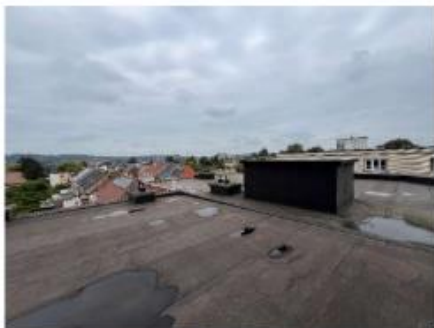
Figuur 1 - Vernieuwd hoofddak
