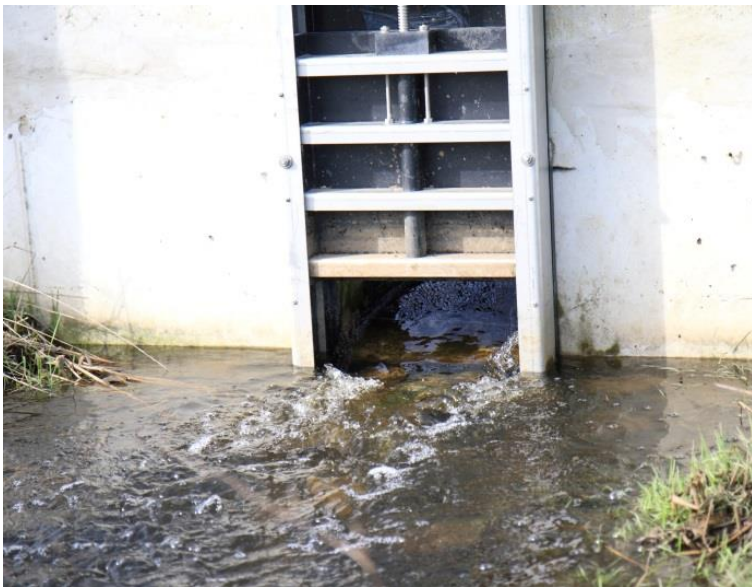
Figuur 1 – Foto van een vispasseerbare stuw aan de Blauwe Gaanweg.
