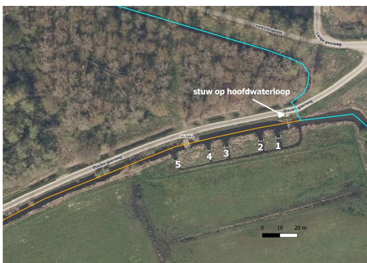
Figuur 2 – Luchtfoto van de vispasseerbare stuwen aan de Blauwe Gaanweg met weergave van de 5 verschillende stuwen die aansluiten op de nevengeul evenals de stuw op de hoofdwaterloop.
