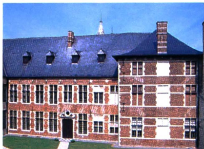
De galerij en de grote zuidvleugel vanaf het westen
