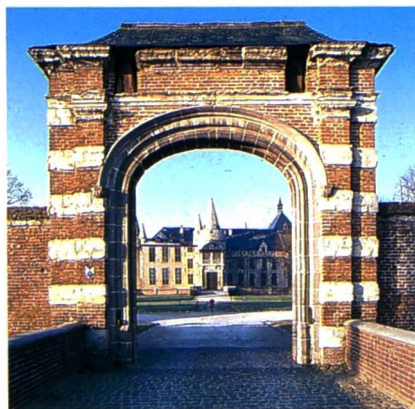
Portaal (voormalige ophaalbrug) aan de buitenwal
