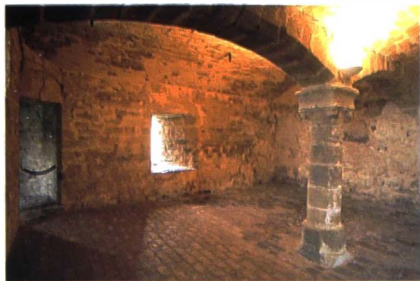
De onderbouw van de donjon
