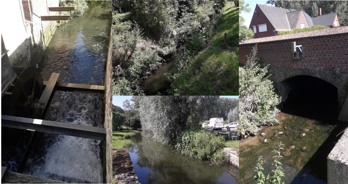
Figuur 3: Foto's van locatie 451. LINKS: Zicht vanaf de molen en stuw. MIDDEN BOVEN: zicht op molenbeek, circa 30m stroomafwaarts van de molen. MIDDEN ONDER: Zicht op Molenbeek stroomop van de stuw. RECHTS: meest stroomafwaartse punt van locatie 451, zicht op de brug waar de Molenbeek onder de Watermolenstraat/Kriephoekstraat gaat.
