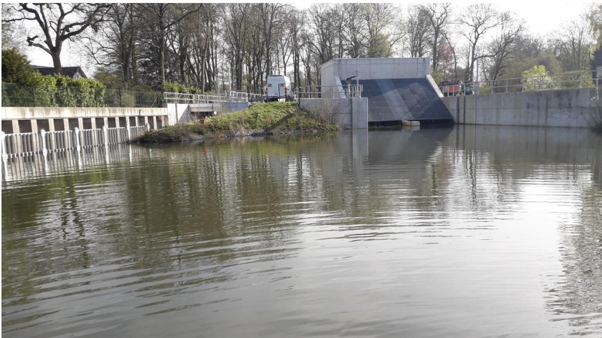
Figuur 1 – Foto van de pompgebraak gelegen op de Rosdambeek.
