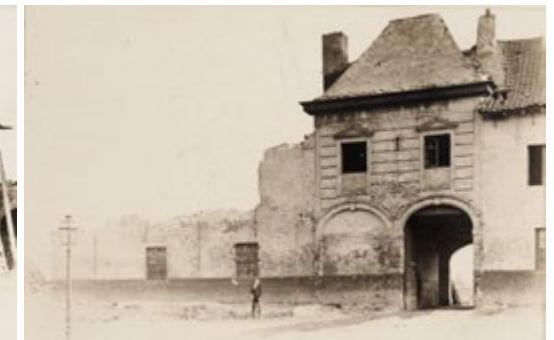
De afbraak van de kazerne aan de Kattenberg, zicht op de toegangspoort aan de binnenplaats, 1899 · © Gent, Stadsarchief · Stedelijke Commissie voor Monumenten en Stadsgezichten
