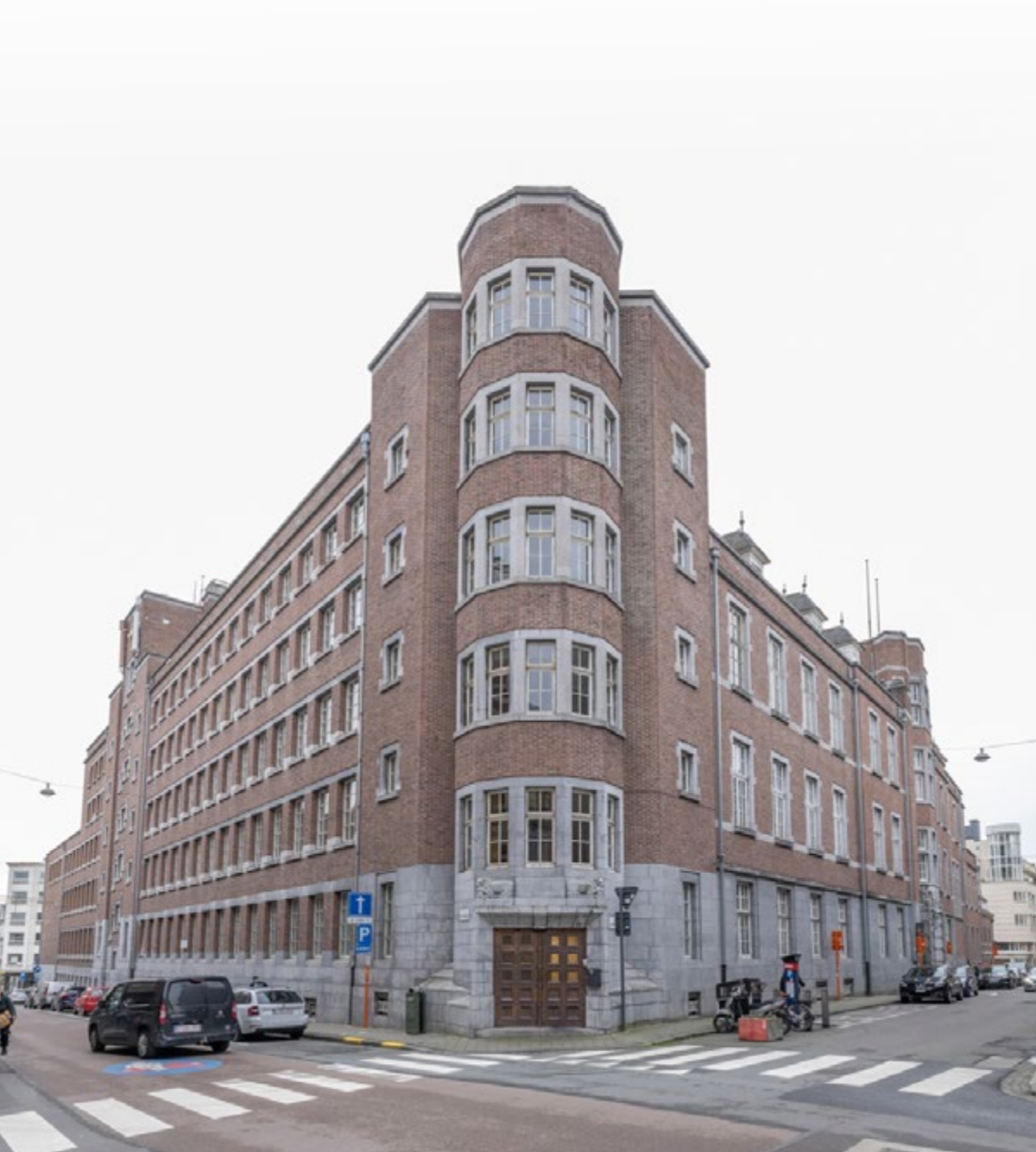
Het voormalige Provinciehuis aan de Gouvernmentstraat
