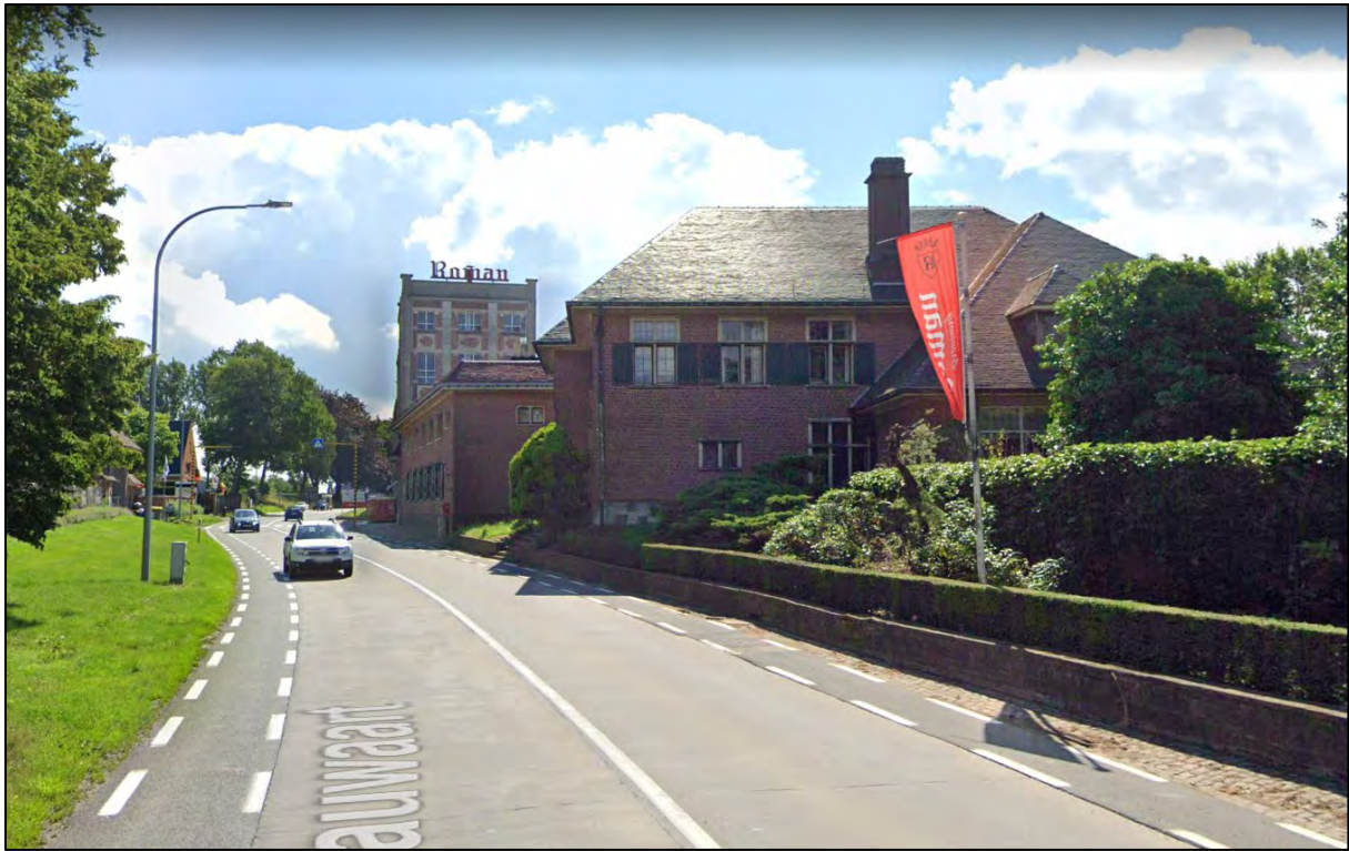
Foto 1: Zicht op Brouwerij Roman vanop de N8 (Bron: Google Street View, juli 2021)
