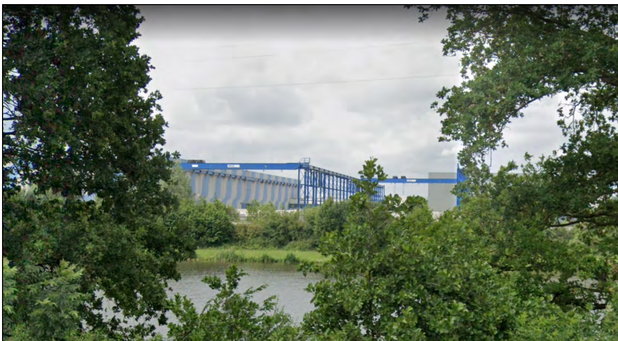
Foto 6: Zicht vanop de N60 op het waterbufferbekken en achterliggend het bedrijf Willy Naessens Construct (Bron: Google Street View, mei 2019)
