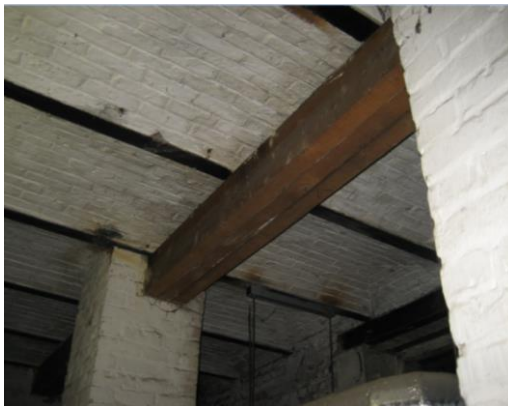
Versteviging vloer gang gelijkvloers
