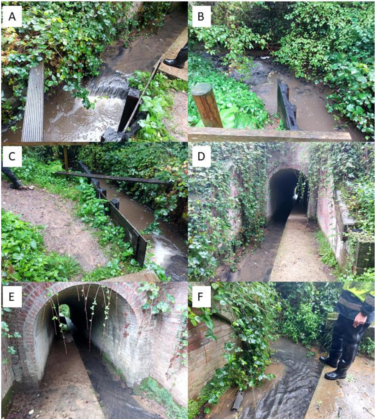
Figuur 4: Vismigratiekelpunt tunnel onder de spoorweg. A, B, C: Verval stroomafwaarts van de tunnel. D: Zicht op tunnel waar de Nederaalbeek deze uitstroomt. E: Zicht op tunnel waar de Nederaalbeek deze instroomt. F: Zicht stroomopwaarts van tunnel waar beek hoek van 90° maakt.
