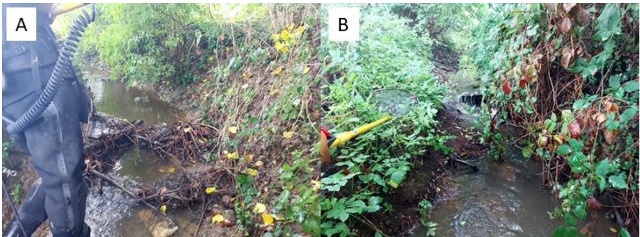
Figuur 3A en B: Kleinere, al dan niet tijdelijke, vismigratieknelpunten in de Nederaalbeek door de opslag van hout/begroeiing/...
