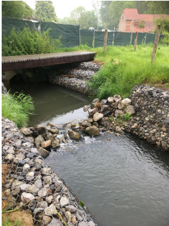
Foto 4: Abrupte en hoge overgang in de vispassage ter hoogte van de Driesmolen.
