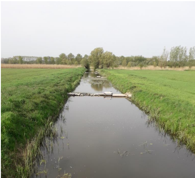
Figuur 1 – Foto van de Rietgracht met een regelbare stuw (rechts) en vistrap (links).
