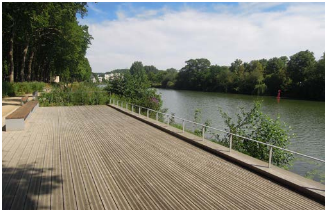
+ Activeren van aanlegplaats aan het water
