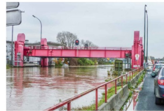
De brug aan de Désiré de Bodtlaai bij overstromingen
