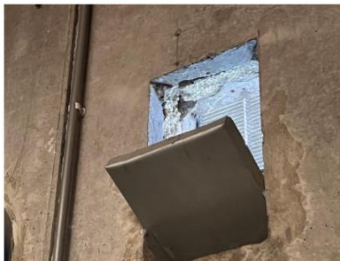
Zicht op de spouwmuurisolatie, zicht op de lichtstraten in de dakpanelen
