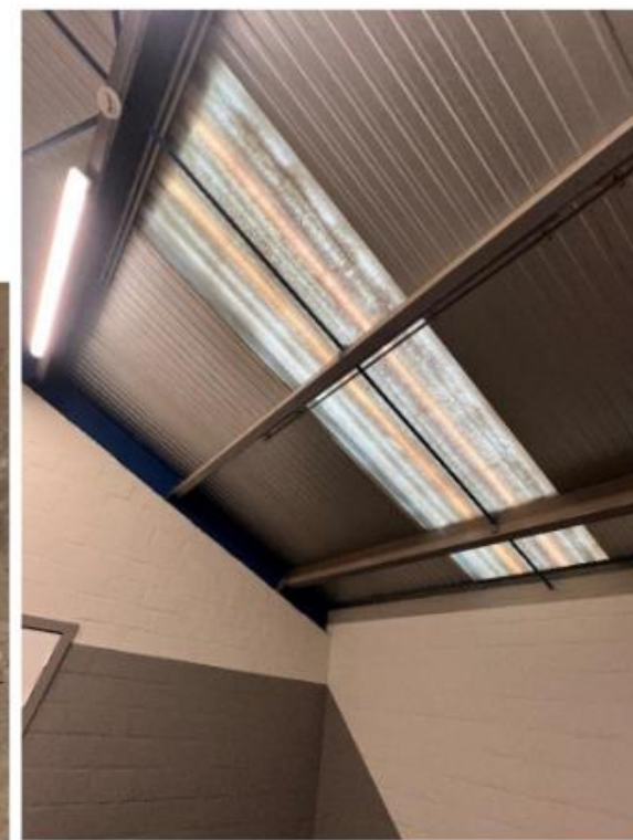
Zicht op de spouwmuurisolatie, zicht op de lichtstraten in de dakpanelen
