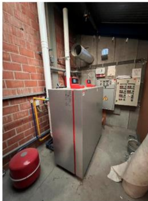
Stooklokaal met 2 gascondensatieketels en sturing. Afgiftesysteem.
