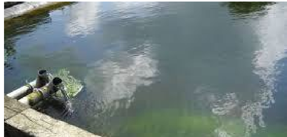
Opslag van drainagewater
