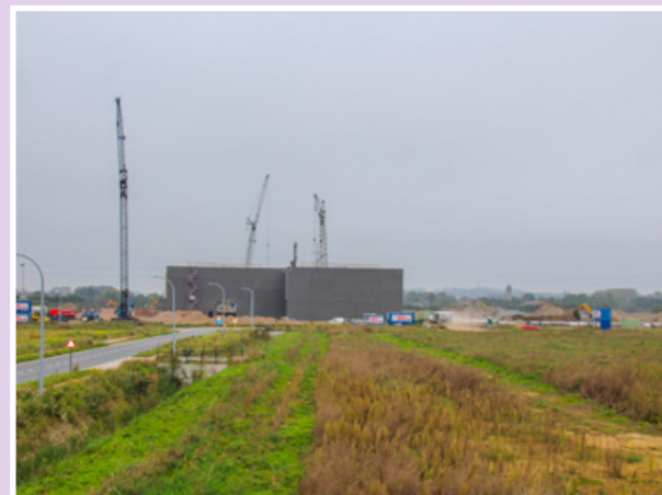
Zicht op het metaalverwerkend bedrijf Vergalle in aanbouw (artikel 1 op het grafisch plan).
