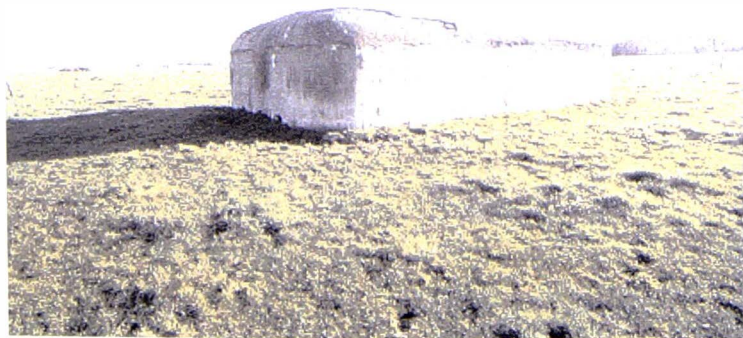
| Grote magazijnbunker M 1. Front- en flankzijde.
