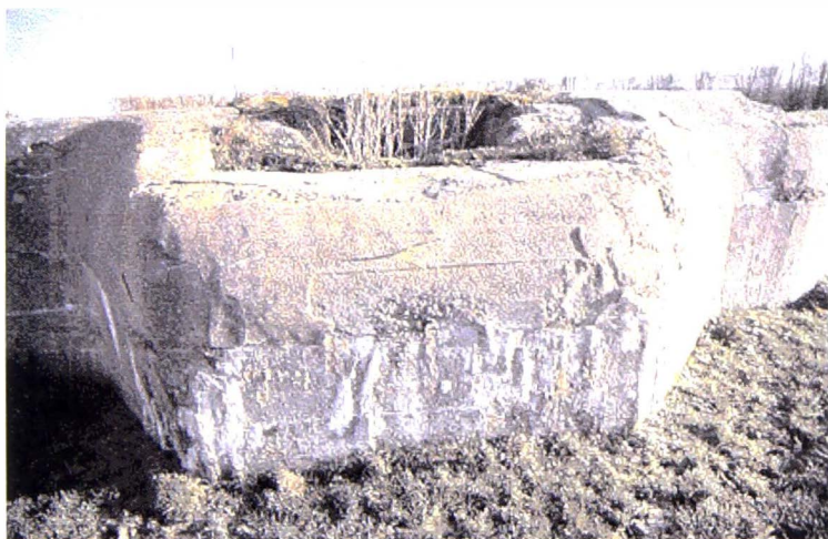
Voorbeeld van een monolietbunker.
