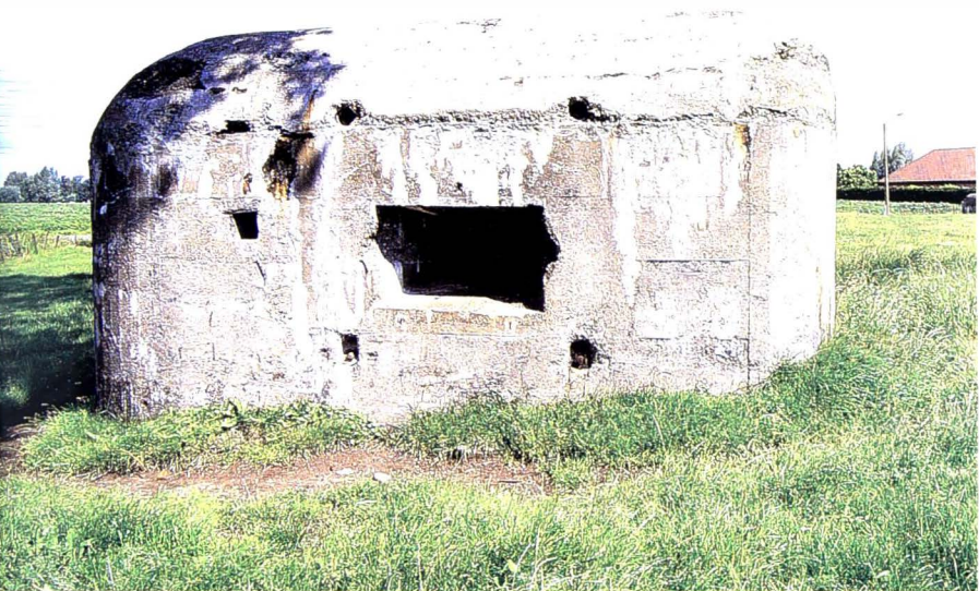
Kanonbunker S 1. Frontzijde.
