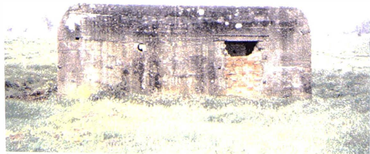
Lichte mitrailleurbunker S 3, frontzijde.
