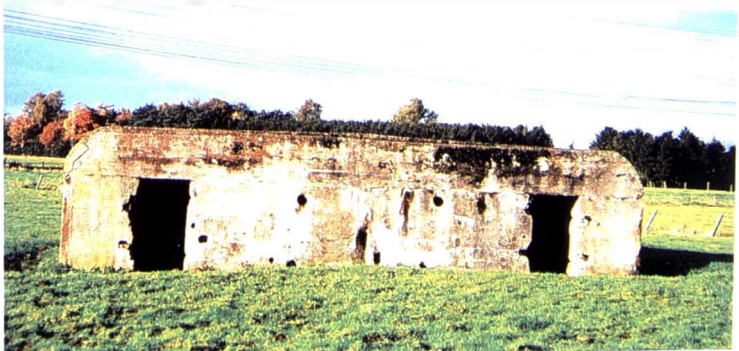
| Troepenbunker T 2. Rugzijde.
