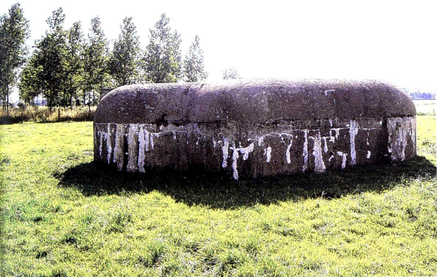
Telefoonbunker Tf. Front- en flankzijde.
