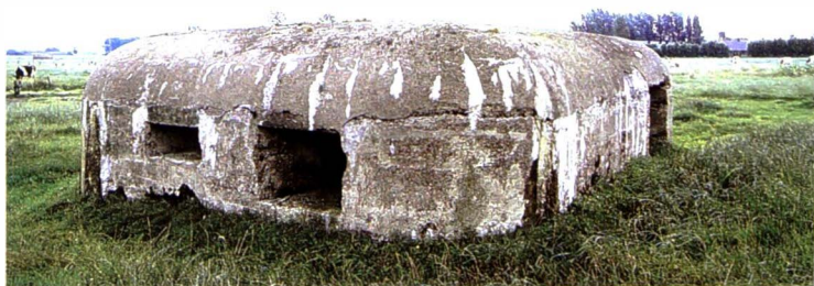
Zware mitrailleurbunker S 2. Front- en flankzijde.
