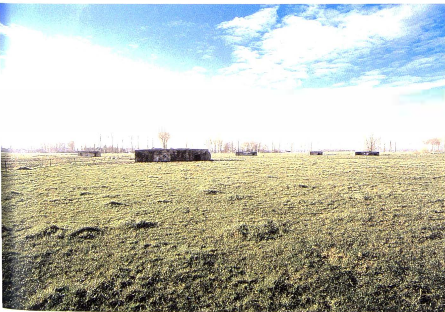
Bunkers in het weidelandschap ten oosten van Vrasene.
