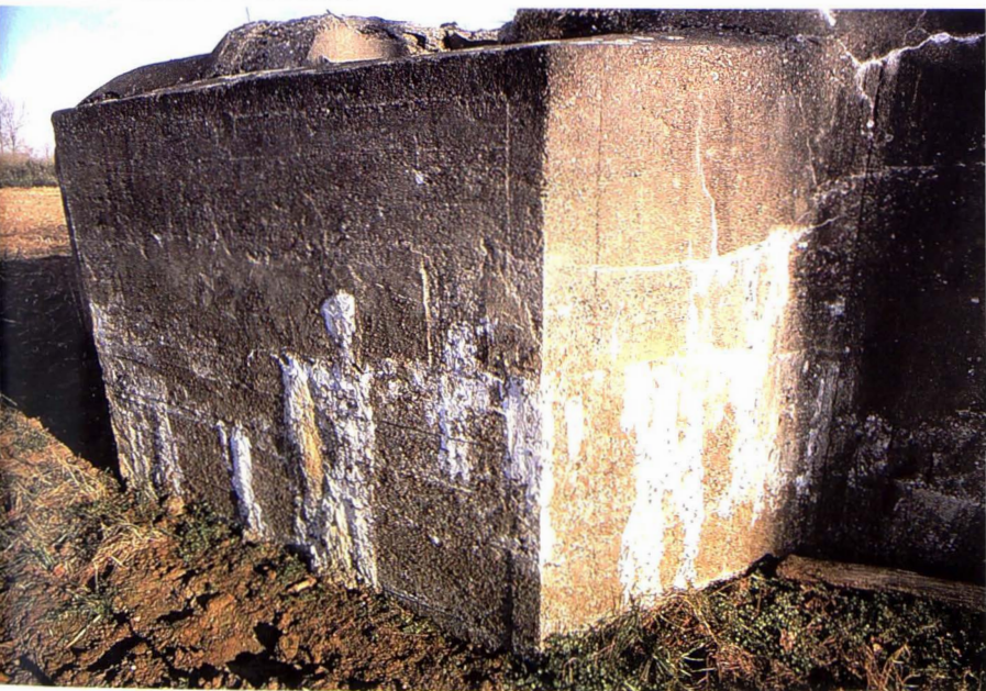
Voorbeeld van een monolietbunker.
