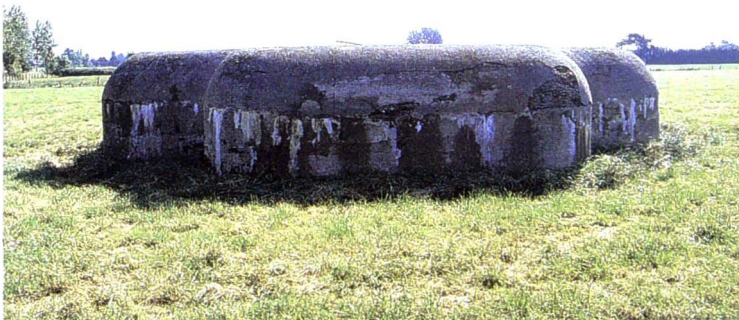
| Troepenbunker T 2. Frontzijde.
