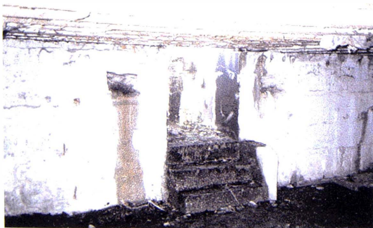
Grote waarnemingsbunker W 3. Interieur.
