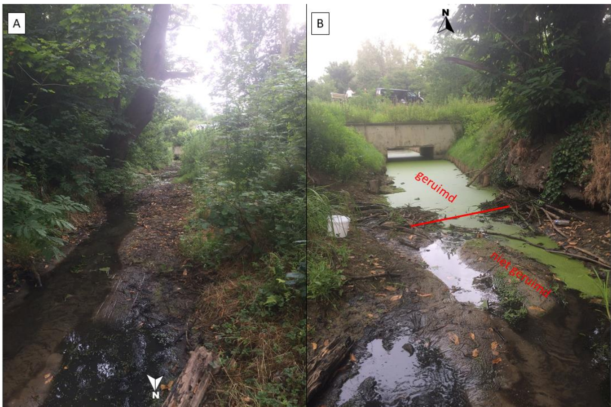
Figuur 11: A. Foto ter illustratie van de lage waterstand in de Loopsloot op 30/06/2022. B. Foto van de Loopsloot waar het verschil in waterstand duidelijk is in een geruimd stuk van de waterloop en een niet geruimd stuk.
