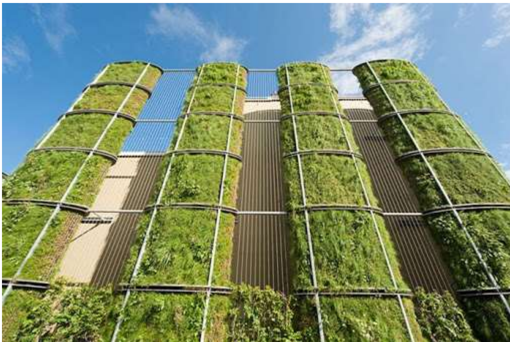
Figuur 17: klimaatadaptieve gevels ( http://groenindebouw.be/inspiratie/groendaken-en-groengevels-voor-klimaatvriendelijke-en-ecologische-bedrijventerreinen )
