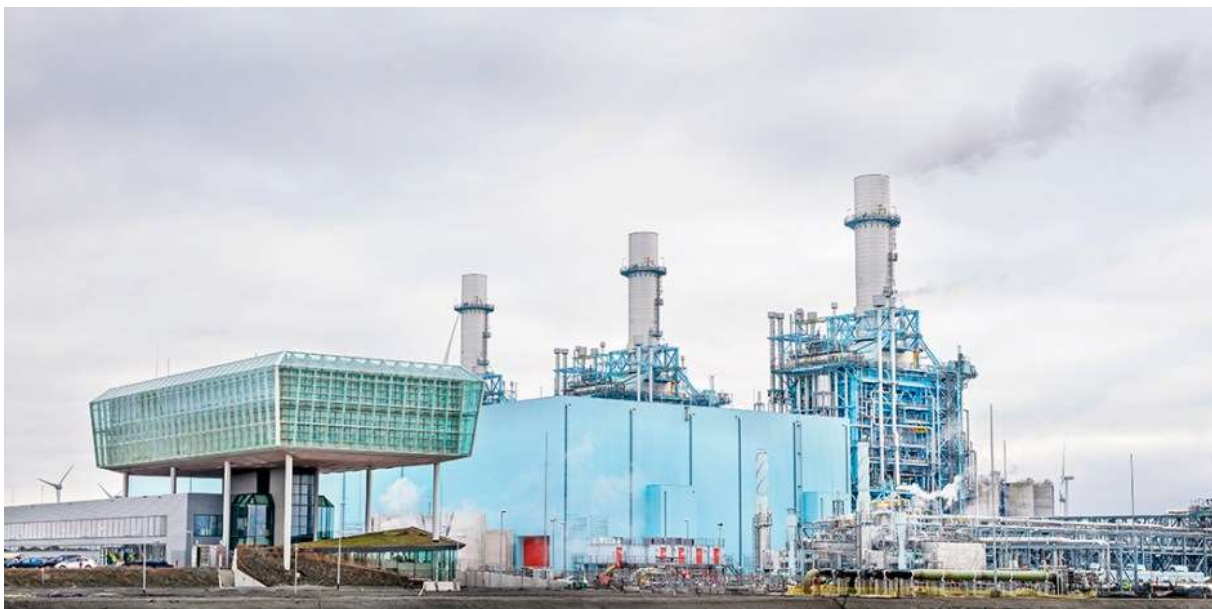
Figuur 7: gascentrale wordt superbatterij - opslag van elektriciteit in ammoniak ( https://bouwuitvoering.nl/vernieuwing/gascentrale-wordt-superbatterij/ )
