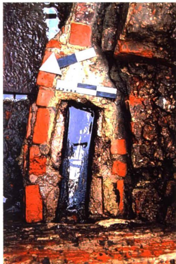
Na het wegnemen van de bakstenen vloer werd de afvoer van het putje zichtbaar.
