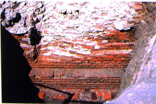
De achterzijde van de nieuwe bakstenen kaaimuur die trapsgewijs ver- breedt.
