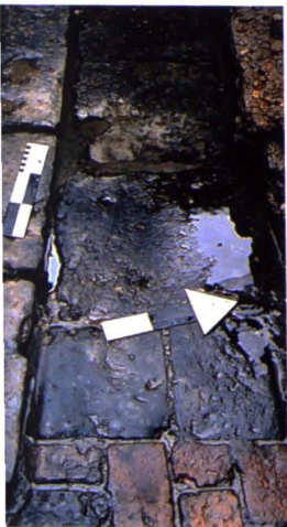
Herstellingswerken met baksteen in de vloer. Links het opstapje.
