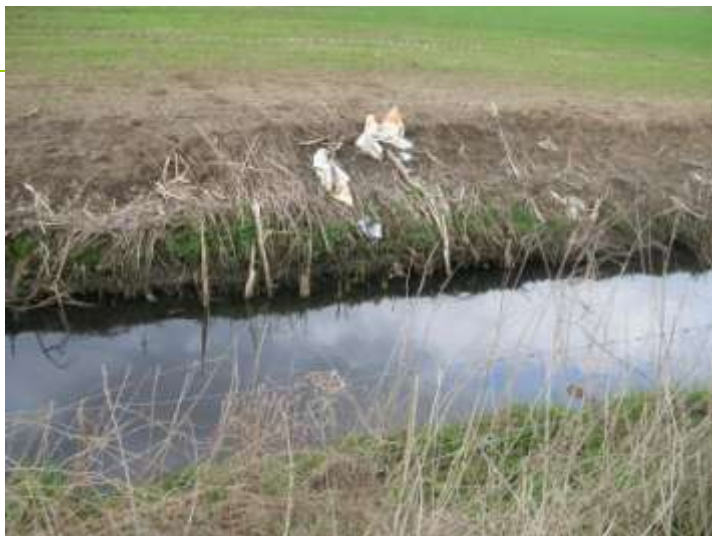
Maaispecie op talud → onstabiele taluds
