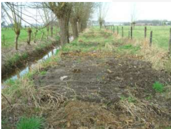
Maaispecie op talud → onstabiele taluds
