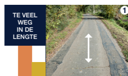
verharde trage weg verhard 2de helft 20ste eeuw
