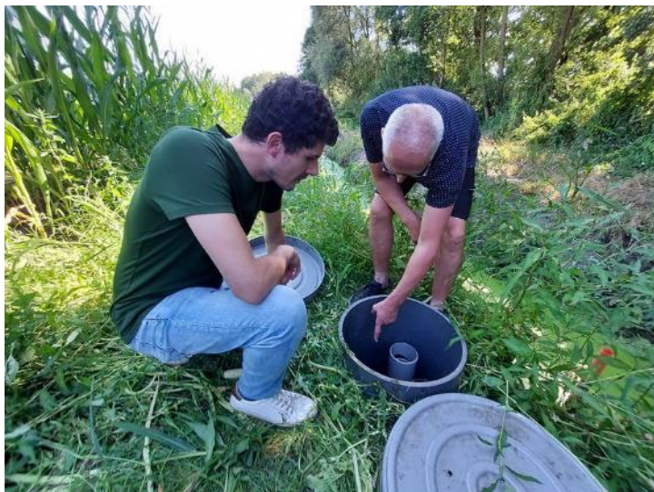
Omvorming naar peilgestuurde drainage
