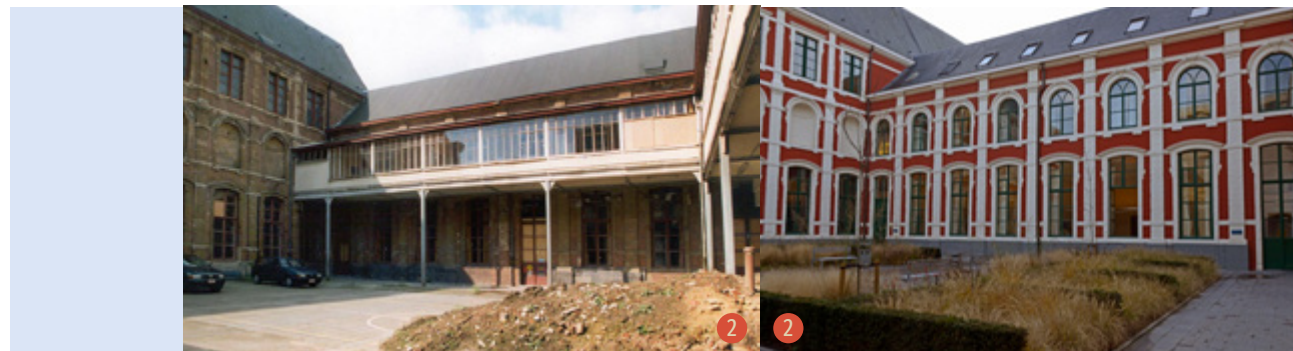
Binnenkoer van het Jezuïetencollege (Braunschool) aan de Voldersstraat voor renovatie. © UGent, foto Hilde Christiaens
