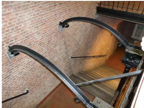
bogen trap verdieping
