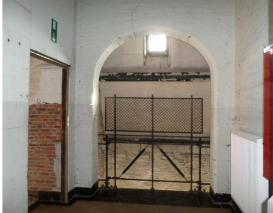
Luik met hekwerk derde verdieping
