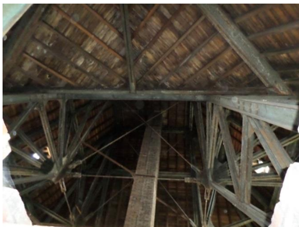
Ijzeren spant in hoofddak middenblok blok G
