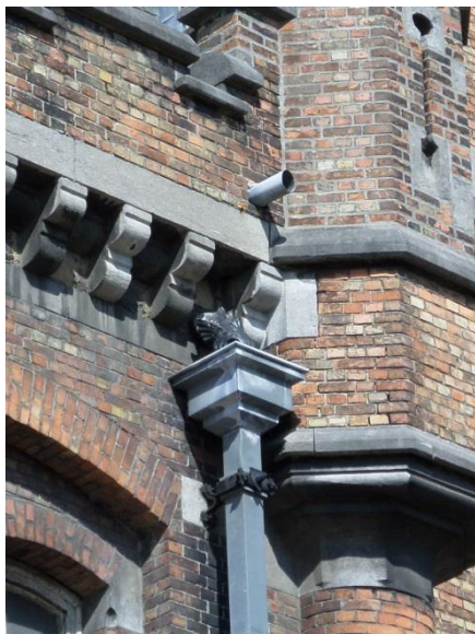
Detail regenpijp met waterspuwer in draakvorm detail anker
