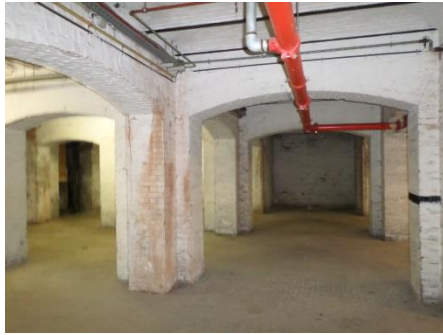
Zicht in de kelderverdieping blok B
