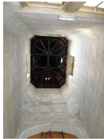
ijzeren spant in tentdak kleine traphal
